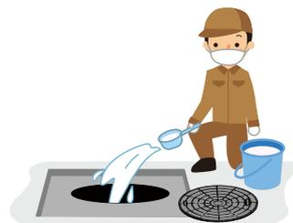
ビルピット・浄化槽内に、クリアウォーターまたはクリアウォーター1に対して水10のスラリー(懸濁液)にしたものを投入します。マンホールだけでなく、トイレ、厨房のシンクやグリーストラップからも投入可能です。投入量は汚水貯留量・処理量・設備の構造によって異なります。
